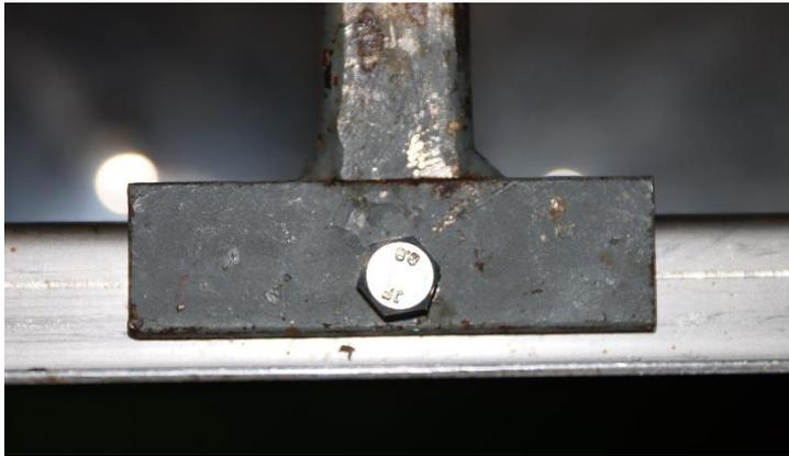
*Bild 4: Die Einlegestange wird beidseitig mit einer 10er Schraube fixiert.*
